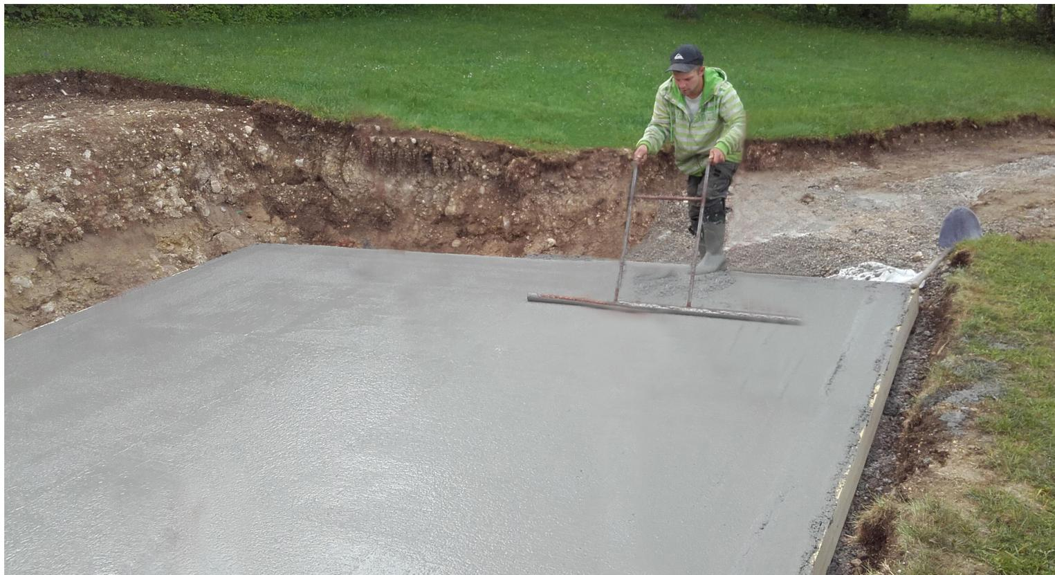
Nota: La losa de hormigón debe tener un espesor mínimo de 10 cm.
